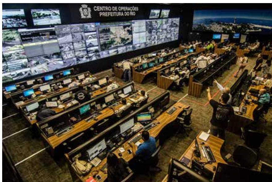
Figura 01: Centro de Operações Rio
